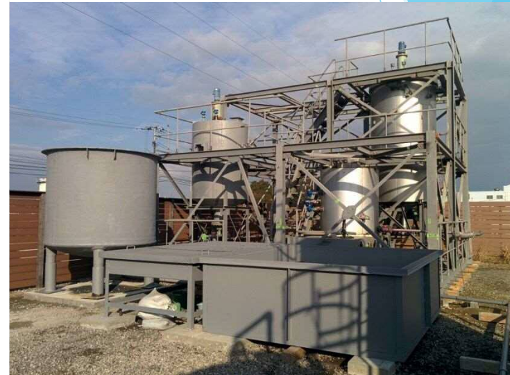
水广场北九州 测试区域A 验证实验进行中
