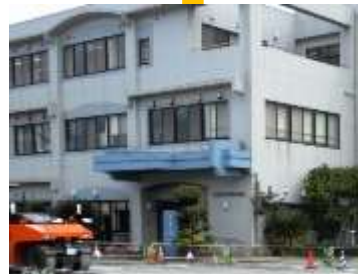
下関漁港福利厚生施設
